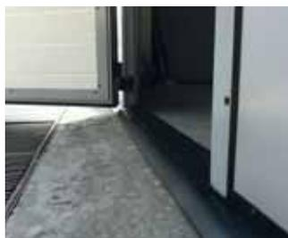
Opzione possibile nel montaggio di porte inserite nel manto, l'ingombro è minimo soli 17 mm
